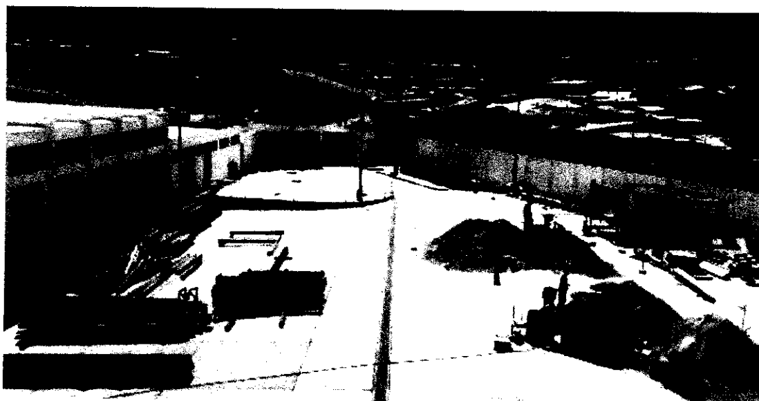
Fotografía N°08: Vista de patio de maniobras donde se aprecian materiales para concreto, defensa de muelles y coberturas.
